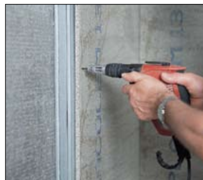
Prinderea pe structură metalică
